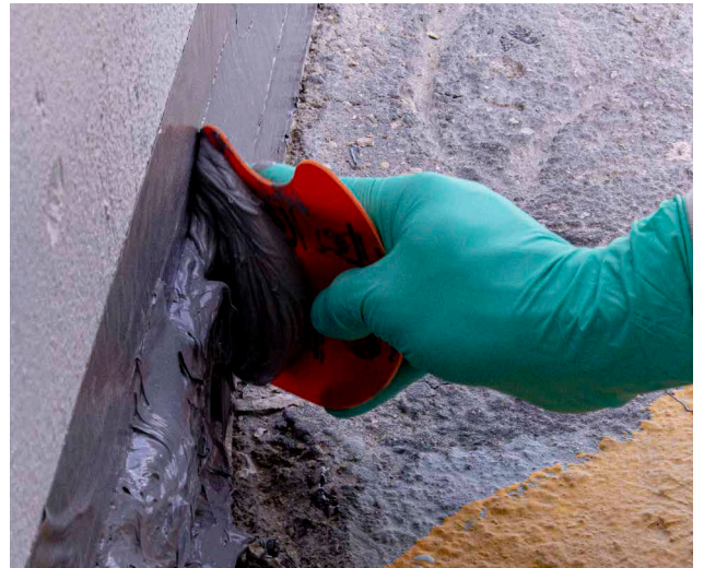
用于在隔离区翻新失效接缝
