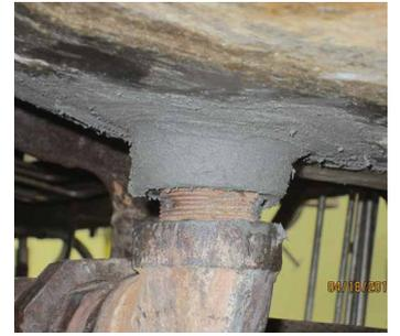
由于腐蚀作用, 工艺容器的焊缝形成了孔洞。使用贝尔佐纳(Belzona) 1511 为这些孔洞提供了持久的修复。
