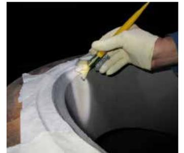
受到严重腐蚀的高温容器使用了贝尔佐纳(Belzona) 1511 重建受点蚀的表面。
