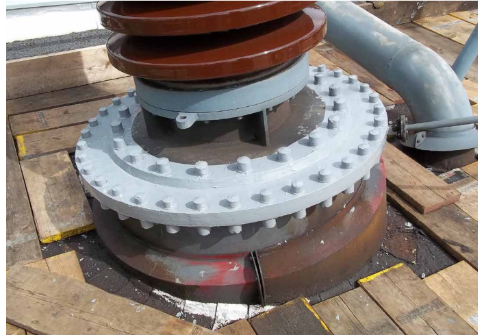
贝尔佐纳(Belzona) 5831 用于变压器油泄漏密封
