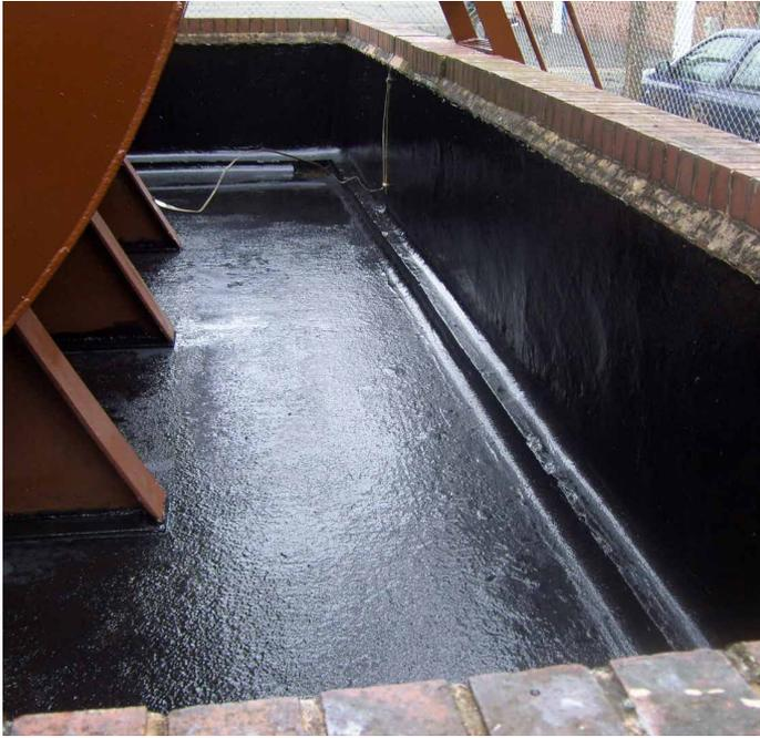
贝尔佐纳 (Belzona) 4351 是一种双组分、静电耗散性涂层, 用于将积聚于表面的静电电荷从危险区域转移走。由于其具有极佳的静电耗散性, 所以, 贝尔佐纳 (Belzona) 4351 有助于消除静电荷在易燃材料贮存区域成为点火源的可能性。
