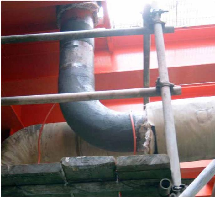
贝尔佐纳(Belzona) 1251 (热激活金属) 是一种单组分系统, 用于在设备运行中为金属表面提供修复和保护。
