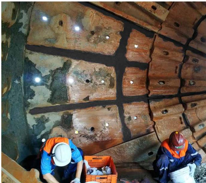
贝尔佐纳(Belzona) 1814 是一种经济实惠的三组分修复系统, 适用于为遭受磨损的表面提供保护。
